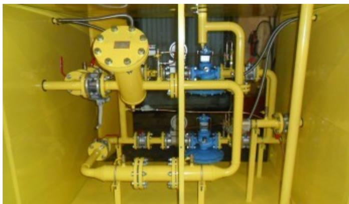
ГРПШ с основной и резервной линиями редуцирования, с узлом учета газа и газовым обогревом. Предназначен для редуцирования высокого или среднего давления на низкое, а также прекращения подачи газа при аварийном изменении заданного уровня выходного давления, учета объема газа. Устройство представляет собой металлический шкаф с размещенным внутри технологическим оборудованием. Для удобства эксплуатации газорегуляторный пункт имеет две двери.
